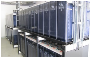
Batería Estacionaria BAE 16 PVS 3040
