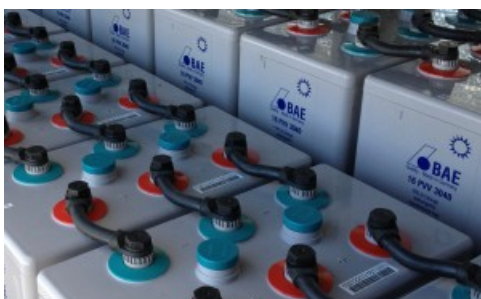
Baterías Estacionarias BAE 16 PVV 3040
